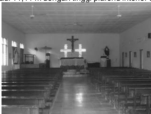
Gambar 2. Interior gereja Cibunut sebelum dilakukan renovasi.
