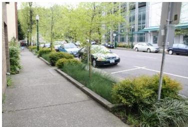
Gambar 13. Penghijauan di Southwest 12th Avenue termasuk strip pavers untuk akses kendaraan parkir (sumber : Webb, 2011)
